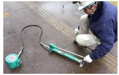
現地での荷重試験
