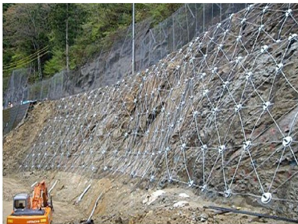
町道和泉白山線法面对策工事 施工完成
