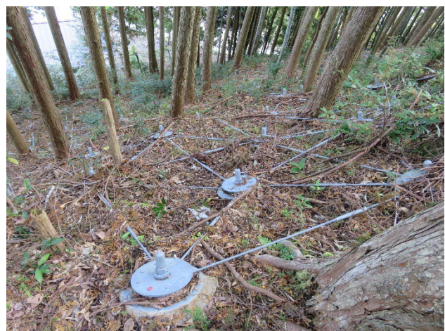
急傾斜地防災崩壊対策工（立木のある自然斜面）
