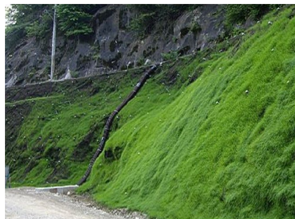
町道和泉白山線法面对策工事 緑化後
