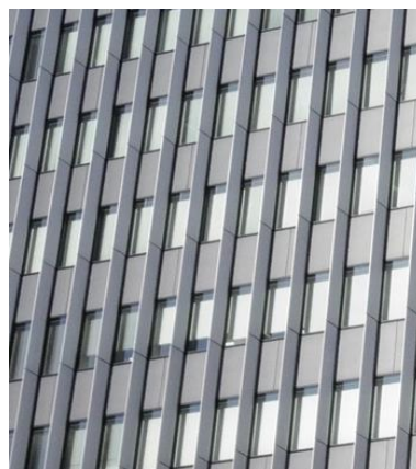
外装ルーバーの例
